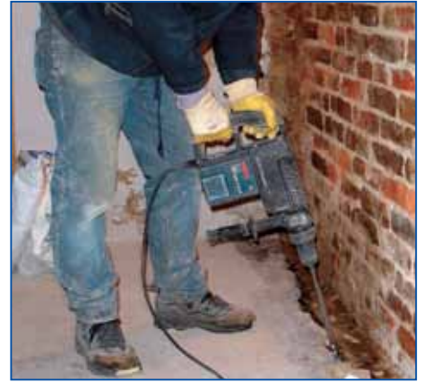
3 Îndepărtați mortarul existent până la o distanță de 30 cm de la îmbinarea cu peretele.
