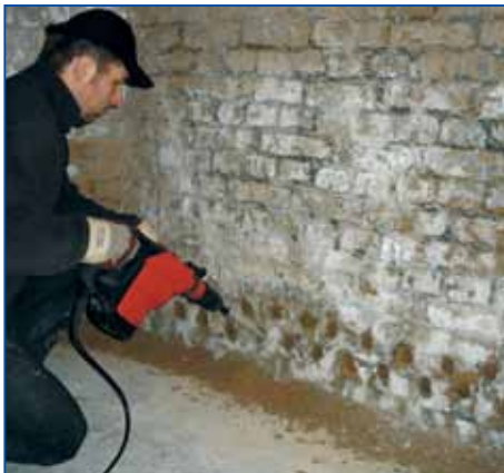
4 Efectuarea găurilor la 10 până la 12,5 cm distanță una de cealaltă. Diametrul găurii variază în funcție de procedura utilizată.
