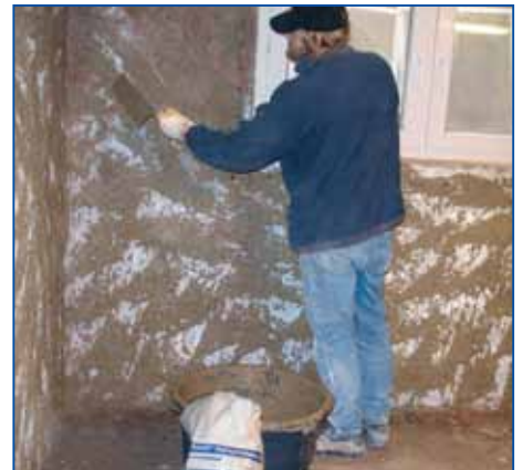
6 Aplicați alternativ INTRASIT® DS1 54Z și INTRASIT® VK 10A . Aplicați de două ori pe zonele umede (sau peste tot). Aplicați apoi un strat de tencuială liant cu suprafață rugoasă INTRASIT® VS-WTA 54Z pentru priză, pentru acoperire completă.
