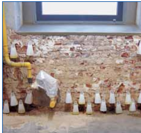
5 Pre-umeziți găurile. Introduceți INTRASIT® VK sau INTRASIT® MEK 180S , INTRASIT® BLK 180S în găuri în secțiunea transversală a peretelui. După etapa de injectare, umpleți găurile cu INTRASIT® BLS 54TR .
