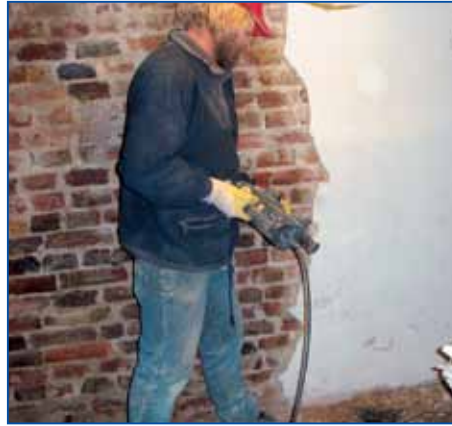
2 Înlăturați complet tencuiala cu încărcătură de sare. Răzuiți mortarul desprins.
