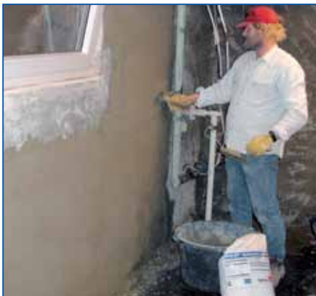
7 Stratul următor de tencuială pe suprafața peretelui cu INTRASIT® SAP-WTA 54Z gri/alb sau INTRASIT® SanUno -WTA 54Z este aplicat în două straturi conform regulilor privind tencuiala.
