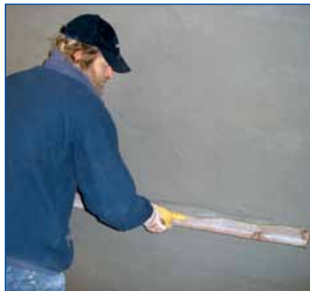
8 Alternativ, pentru tencuielile groase sau pe zidăria care prezintă fisuri multiple, se poate aplica INTRASIT® SanUno-WTA 54Z într-un strat cu o grosime de până la 30 mm.
