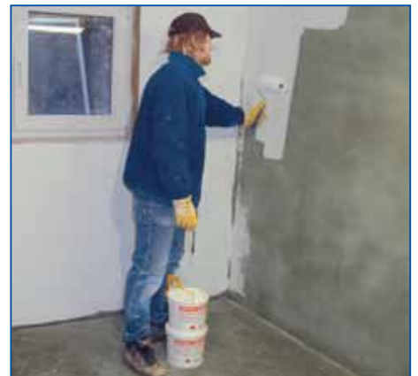
9 Stratul final al suprafeței de tencuială pentru renovare poate fi realizat numai cu sistemele permeabile la vapori de apă. Utilizați VESTEROL® SF 10A ca vopsea.
