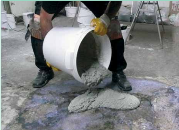
Se amestecă HADAPLAN® BM cu apă până la obținerea unui ciment omogen pentru netezire.
