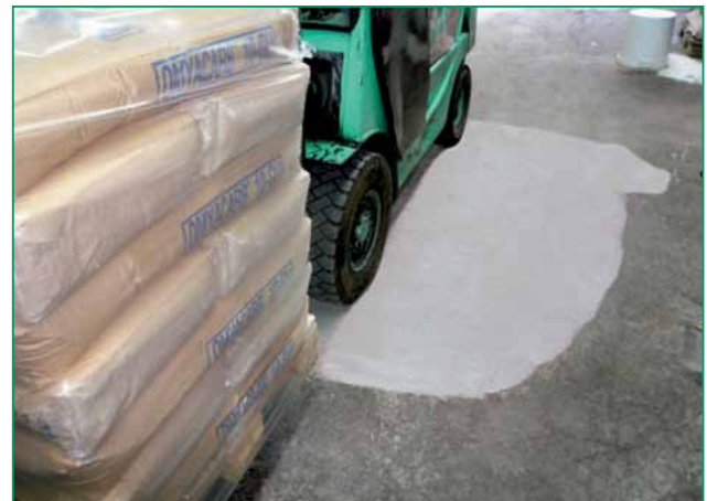
După numai 90 de minute timp de întărire, HADAPLAN® BM este foarte rezistent - aici, de exemplu, cu un stivuitor cu sarcină de aproximativ 1000 kg pe fiecare roată.
