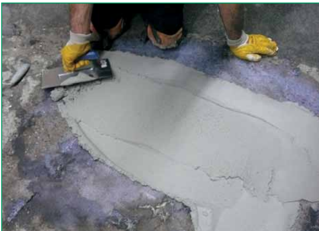
Cu o mistrie, nivelați, îngroșați și egalizați HADAPLAN® BM .
